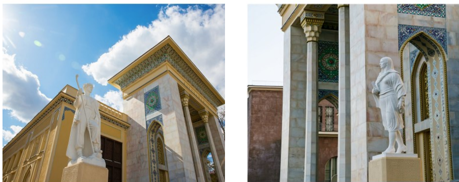
Рисунок 12. Боковые фасады павильона №14
