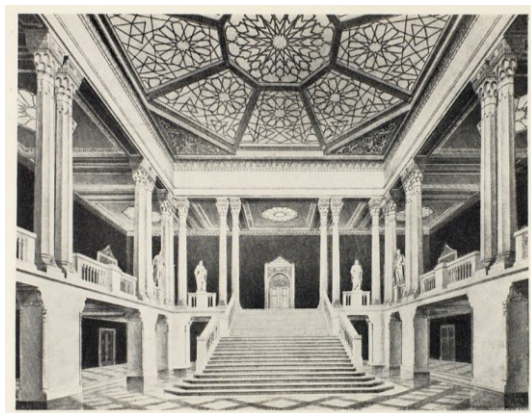
Рисунок 19. Центральная лестница в главном здании Академии наук
