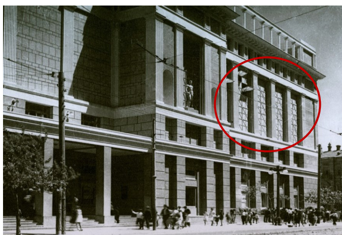
Рисунок 5. Остеклённые фрагменты фасада к/т. «Низами»
